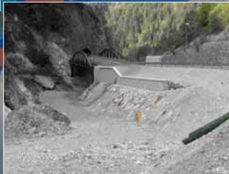
Stessa zona dopo gli interventi di ripristino
